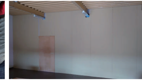
▲ 倉庫改修工事
